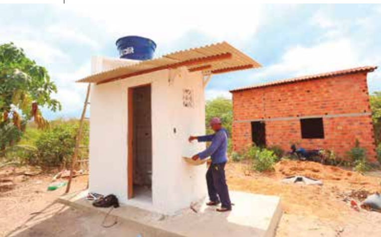
A instalação de Kits Sanitários é uma ação do Governo do Estado que visa diminuir o déficit de banheiros ou sanitários
