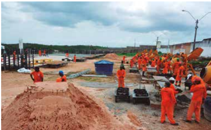
Encarcerados recebem remissão de pena ao trabalhar na fábrica de blocos de concreto para melhoria e construção das unidades prisionais.
